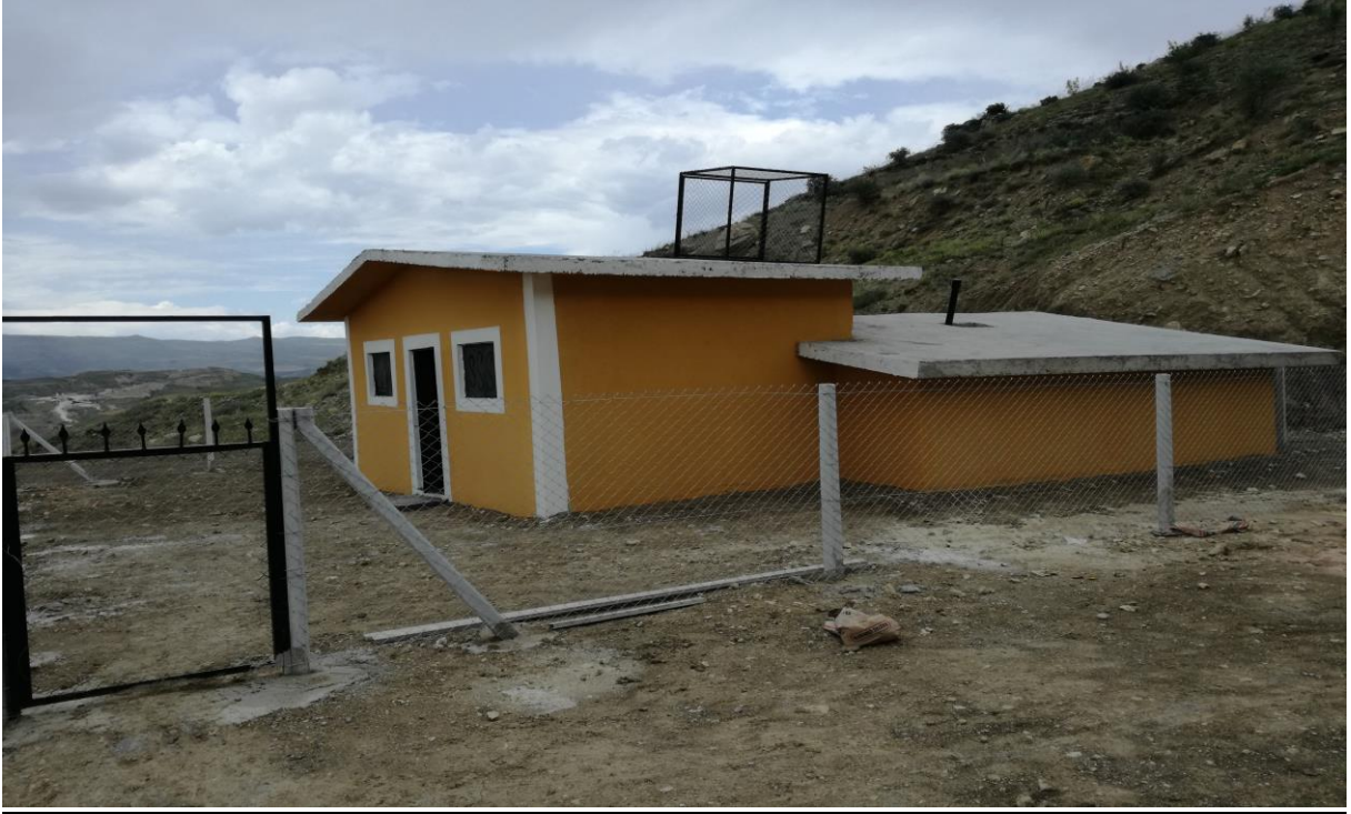
İÇME SUYU DEPOSU
